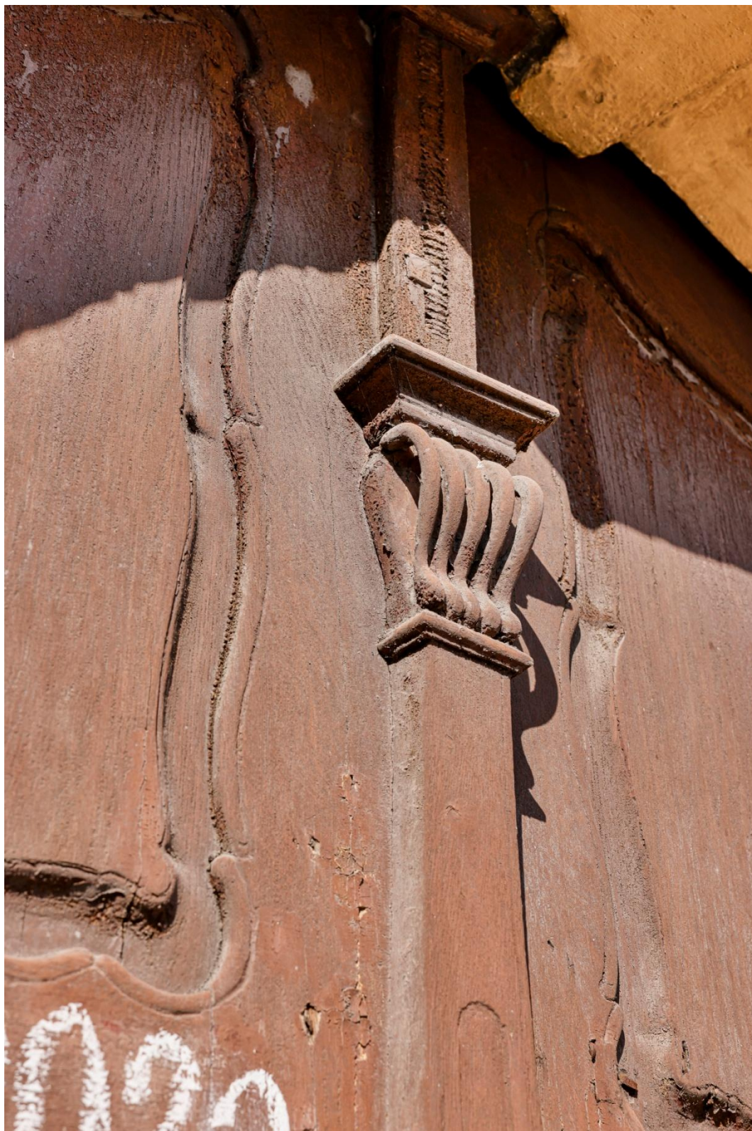
Obr. č. 5 Detail – vnější strana – stav při průzkumu – ukázka poškození horní části Povrchová úprava je dožilá, jednotlivé vrstvy se uvolňují a odpadají. Dožilou úpravu bude nutné kompletně odstranit.
