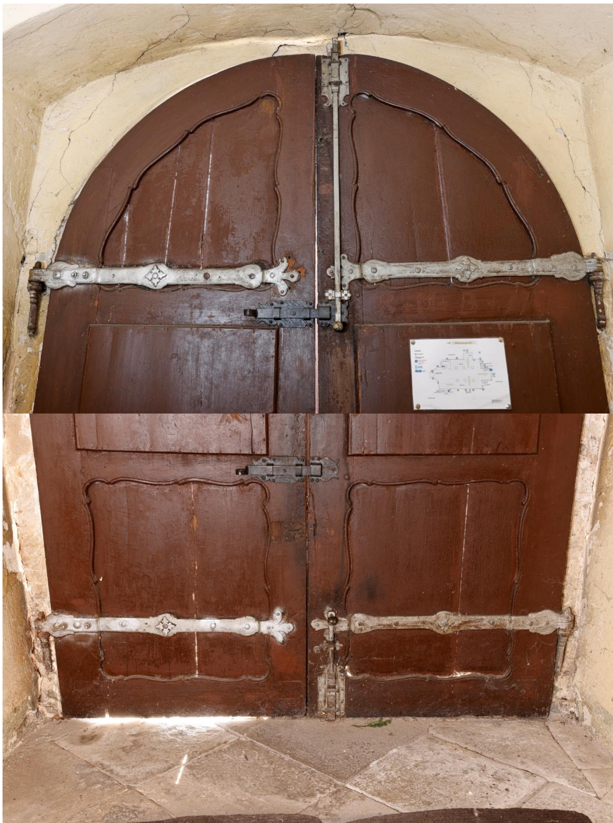
Obr. č. 8+9 Detail – vnitřní strana – stav při průzkumu – kování Většina kování je kromě zámku s klikou pravděpodobně původní. Na snímku je patrné, že s kováním bylo manipulováno a řada upevňujících prvků je již vyměněna. Povrchová úprava stříbrenkou napodobuje cínování, které mohlo být na některých prvcích použito. Stříbrný nátěr je proveden jako vrchní na hnědý nátěr shodný s nátěrem dveří.
