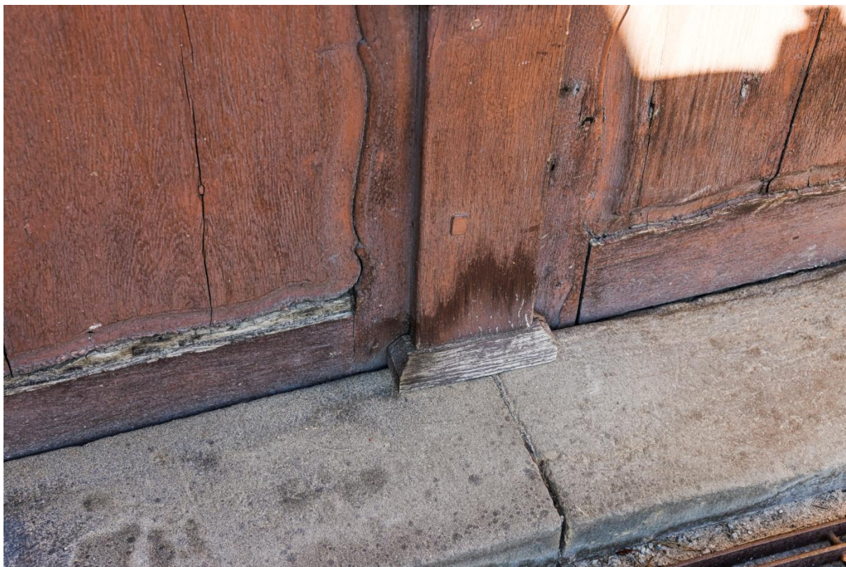
Obr. č. 4 Detail – vnější strana – stav při průzkumu – ukázka poškození ve spodní části Trhliny a mezery mezi jednotlivými konstrukčními částmi byly vyplňovány tmely. Tyto tmely jsou rozpraskané a odpadají. Tmely z větší části chybí, takže do mezer zatéká a voda poškozuje dřevní hmotu, která je napadená hnilobou. Při restaurování bude potřeba dožilé nátěry i s tmely kompletně odstranit. Napadené a dožilé části bude nutné nahradit materiálovými a tvarovými kopiemi.
